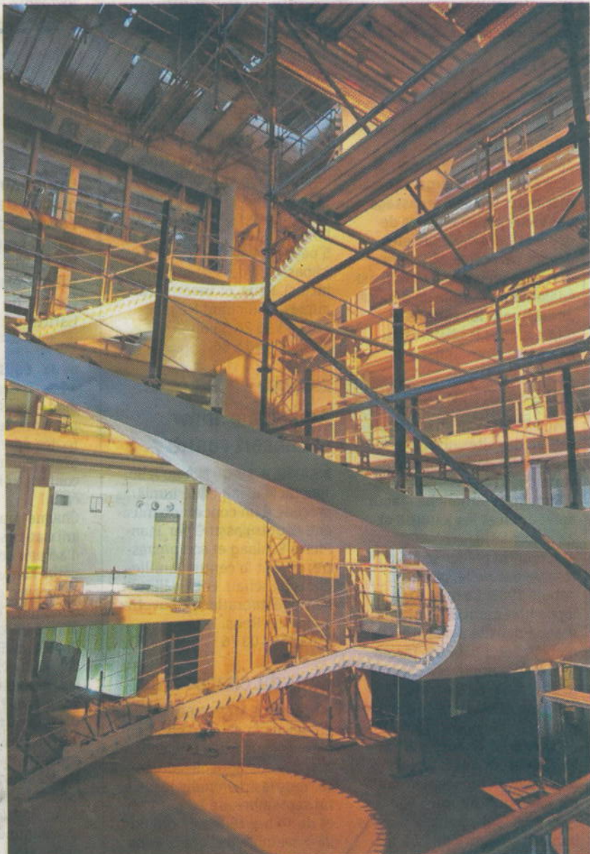
L'escalier central de la BNU : manquent encore les haubans qui le relieront à la coupole.
